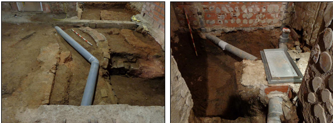
Vista des del nord-est de les clavegueres de PVC u.e. 108, 174 i 175 amb el registre u.e. 176.
