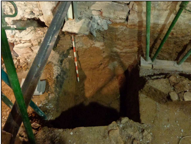
Vista final del sondeig realitzat a l'estrat sorrenc u.e. 170-171 a la cantonada est de l'habitació per construir una fonamentació de pilar de formigó.
